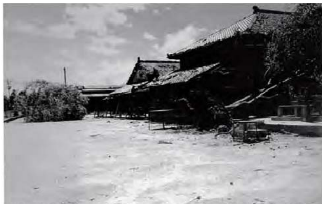
なぎ倒された大木（甲府市・昭和34年） 国母小学校では、校庭の大木が強風で根こそぎ倒された。校庭に横たわる大木が風の強さを物語っている。屋根の瓦も吹き飛ばされている。
