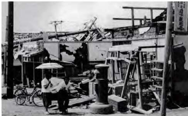
屋根を吹き飛ばされた家（甲府市・昭和34年） 山梨大学前の惨状。屋根は吹き飛ばされ、壁は打ち破られており、暴風雨の猛烈さが伝わってくる。台風のスビードが速すぎて防災対策が間に合わなかったこともあり、未曾有の大災害となった。
