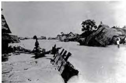
甲運地内の被害状況
