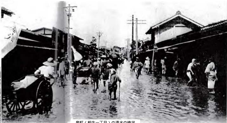
泉町(相生一丁目)の浸水の惨状
